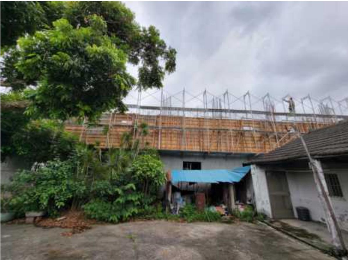
111/6/29從整地開始一路平均一個半月往上長一樓，目前已經蓋到三樓頂了，明天將進行綁鋼筋作業，再來就是水電埋管作業，下週就能進行灌漿作業了，站在路旁看過去非常的醒目。
